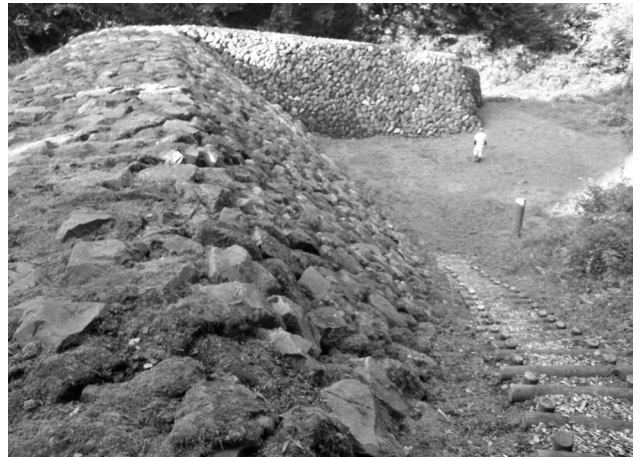
松ヶ端えん堤
