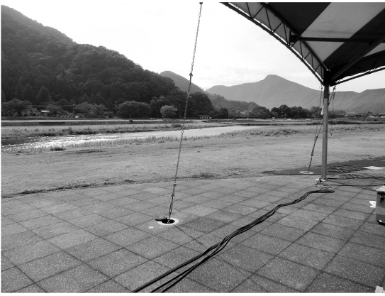
〈図—12〉昨年度施工された河川公園内のアンカー
