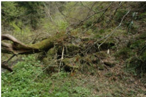
堤体には雑木が生え、特に天端では高木となって倒木し、石積みが崩壊しています。雑木を伐採し、流木を取り除き一部石積を整備する必要があります。標識を建て歴史的砂防施設の教材にしたいと提案します。
