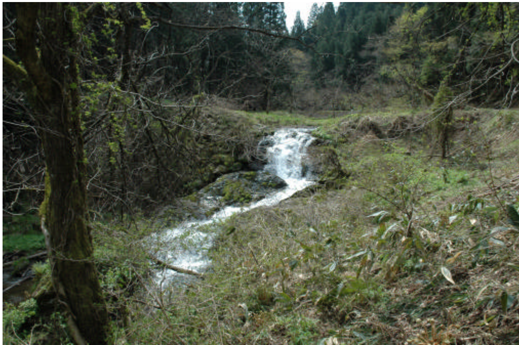
大鶴見川砂防石積下堰堤 2006 年 4 月 30 日撮影 :Y.TANAKA
